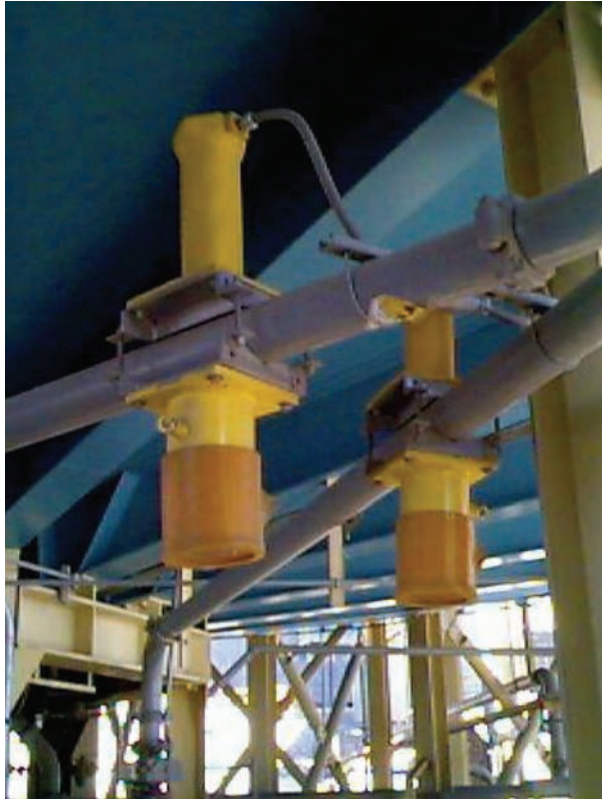
FIG. 66. Jauges de densité en position sur des canalisations.
