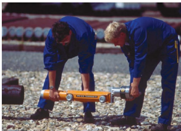
FIG. 59. Introduction d'un dispositif d'inspection interne dans une canalisation ouverte (photographie : MDS Nordion).
