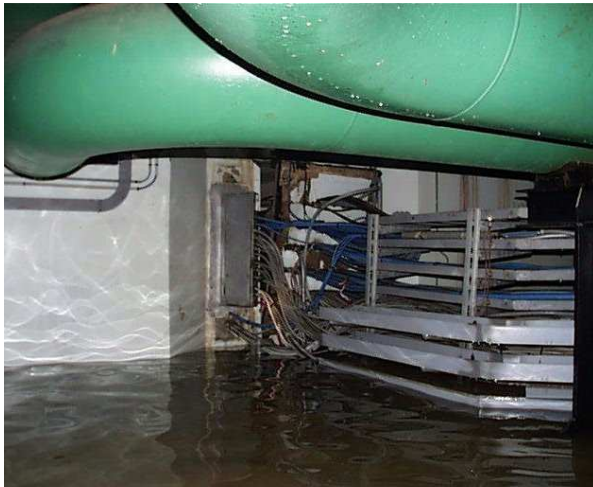
Bâtiment combustible Tranche 2 niveau - 8,50 m Local K 054 Trémie électrique éventrée
