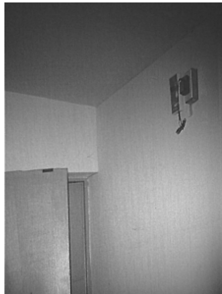
Figure 5 Posición del detector de Alerta temprana en acceso principal a la unidad de Braquiterapia y Medicina Nuclear, ubicación interna, además en la parte superior de la puerta se observa un interruptor magnético que alerta de la salida o entrada de personas.
