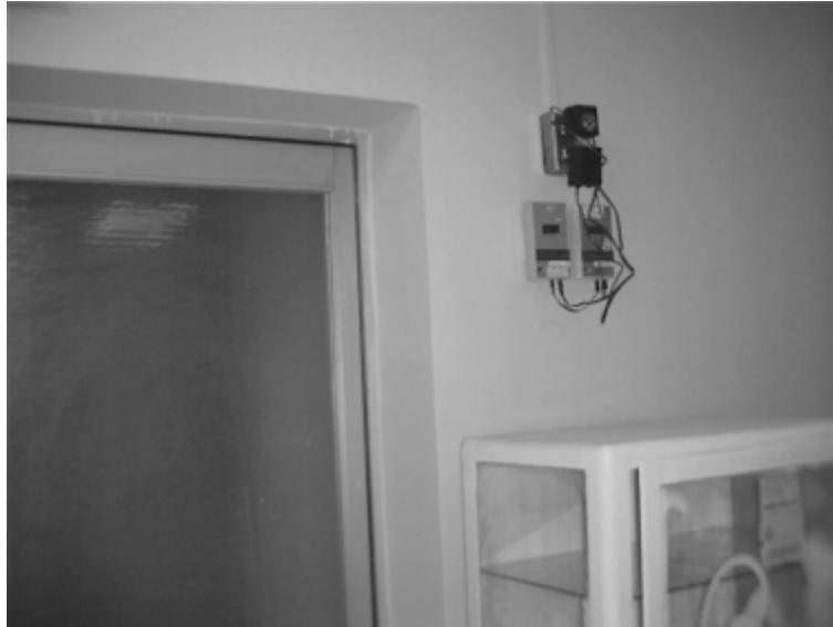
Figure 4 Sala de hospitalización con capacidad para seis pacientes, existe un paramédico de día y noche para verificar la condición de los pacientes, el movimiento de las fuentes solo se realiza al interior de la unidad.
