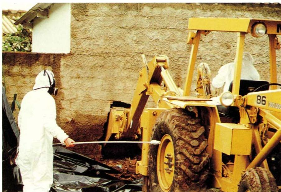
10. Пробито отверстие для удаления источника излучения с мощностью дозы  $0,5 \text{ Зв} \cdot \text{ч}^{-1}$
