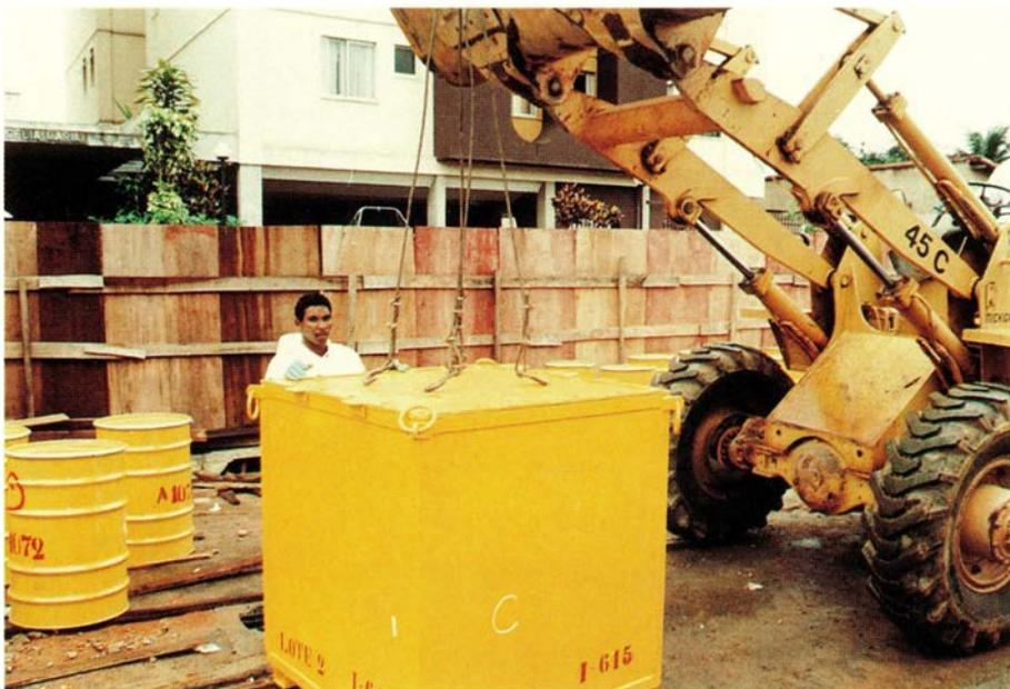
20. Один из специально изготовленных 5-тонных контейнеров для хранения отходов.
