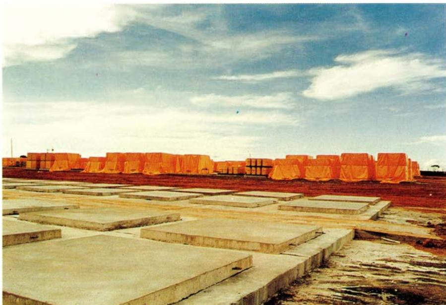
*24. Место временного хранения; показаны бетонные основания с каналами для отбора проб стекающей воды.*
