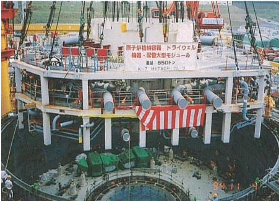
*Fig. 5.10. Installation of upper drywell super large scale module (Kashiwazaki-Kariwa).*
