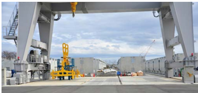
РИС. 18. Временное «сухое» хранилище транспортно-упаковочных контейнеров на АЭС «Фукусима-дайити» Токийской электроэнергетической компании (ТЕПКО).
