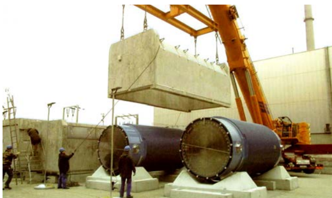
РИС. 20. Временное горизонтальное хранение в Германии (публикуется с разрешения «Гезельшафт фюр нуклеар сервис»).
