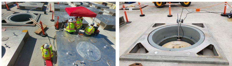
РИС. 70. Инспекция системы МЦК UMAX на СОНГС: рабочая зона инспекционной бригады (слева) и робот с камерой высокого разрешения, установленный внутри модуля хранения UMAX (справа). (Публикуется с разрешения SCE.)
