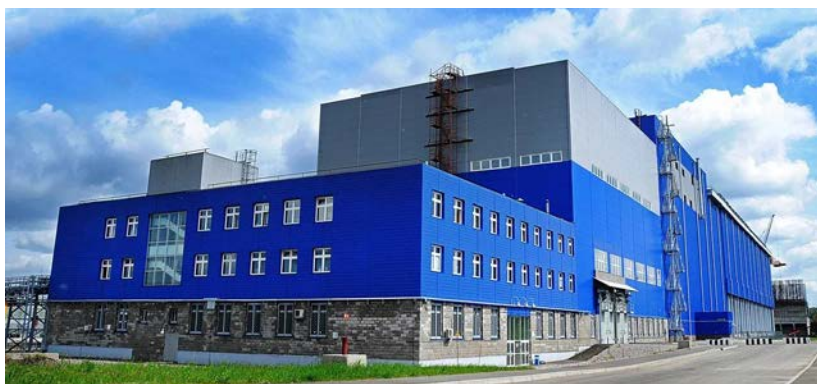
РИС. 58. Общий внешний вид «сухого» хранилища отработавшего топлива РБМК.
