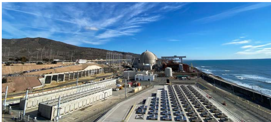
РИС. 67. Системы хранения отработавшего топлива СОНГС: TN NUHOMS (слева) и Holtec UMAX (справа). (Публикуется с разрешения SCE.)
