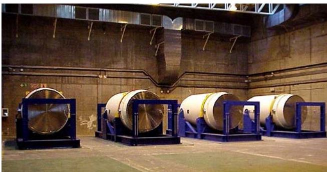
РИС. 19. Горизонтальное хранение на АЭС «Куберг», Южная Африка (публикуется с разрешения «Гезельшафт фюр нуклеар сервис»).
