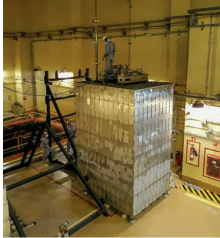
РИС. 9. Стеллаж для хранения топлива реакторов с водой под давлением (PWR). Публикуется с разрешения АНАВ (Ядерной ассоциации «Аско-Вандельос II»).
