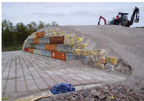
Рис. 16. Захоронение ОНАО: захоронение траншейного типа в пункте захоронения «Эль-Кабриль», Испания (фото: «Энреса») (слева) и курганное захоронение на АЭС «Оскарсхамн», Швеция (фото: «Svensk Kärnbränslehantering») (справа).
