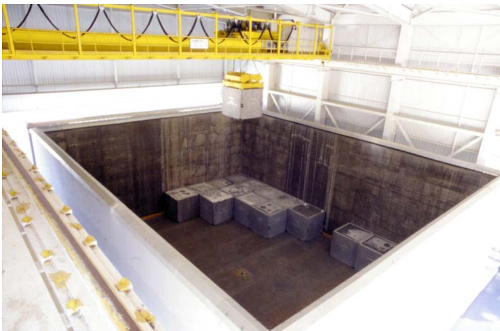
РИС. 23. Заполнение камеры захоронения в пункте захоронения НАО «Эль-Кабриль» (фото: «Энреса»).
