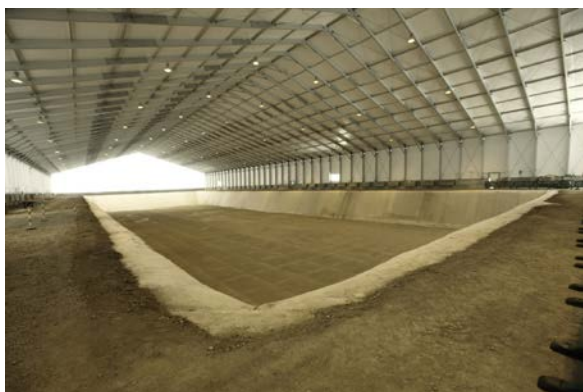
Рис. 16. Захоронение ОНАО: захоронение траншейного типа в пункте захоронения «Эль-Кабриль», Испания (фото: «Энреса») (слева) и курганное захоронение на АЭС «Оскарсхамн», Швеция (фото: «Svensk Kärnbränslehantering») (справа).
