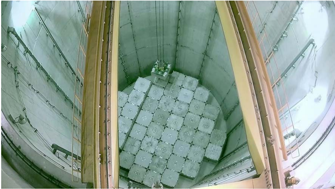
РИС. 31. Размещение отходов в цилиндрическом бункере в Центре по захоронению радиоактивных отходов низкого и среднего уровня активности «Вольсон», Республика Корея (фото: КОРАД).
