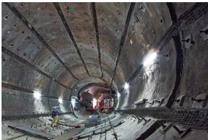
Рис. 48. Строительство транспортной выработки в пункте захоронения «Конрад», Германия (фото: Bundesgesellschaft für Endlagerung mbH).
