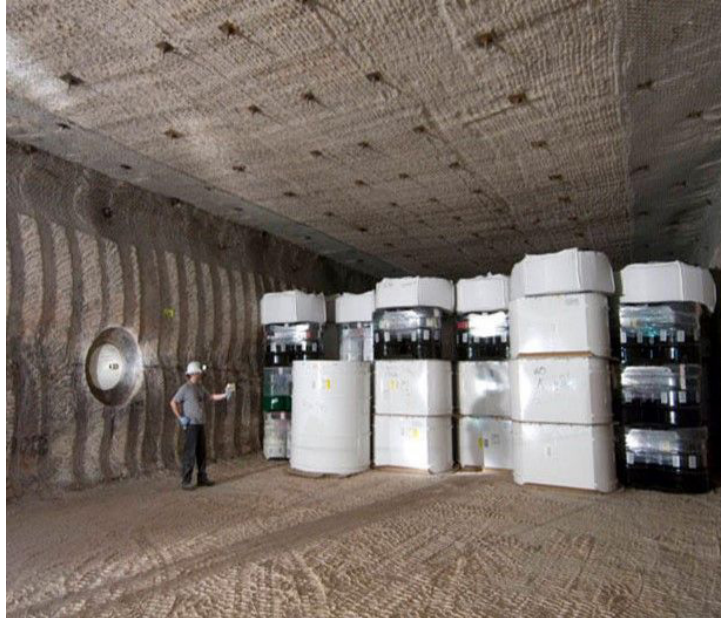
РИС. 43. Операции по захоронению отходов в комплексе «WIPP» (США); показаны упаковки отходов, транспортно-технологические операции с которыми выполняются в дистанционном и контактном режимах (фото: Министерство энергетики США).
