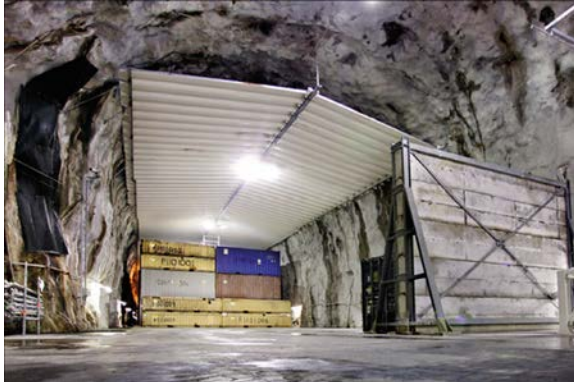
РИС. 33. Камеры захоронения НАО в пункте захоронения «SFR», Швеция (фото: «СКБ»).
