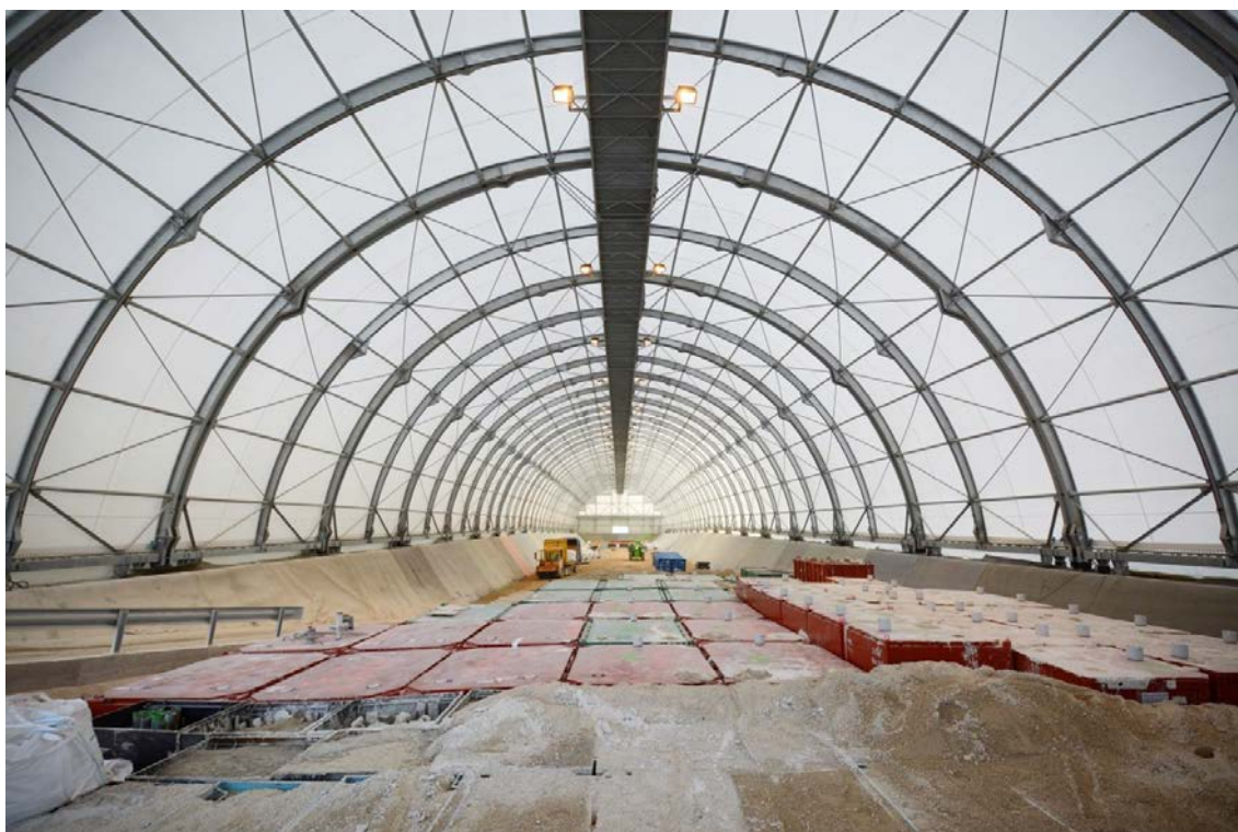
РИС. 18. Система тентового укрытия «Premorail» над заполненной траншеей в центре «CIREС» (фото: «Андра»).
