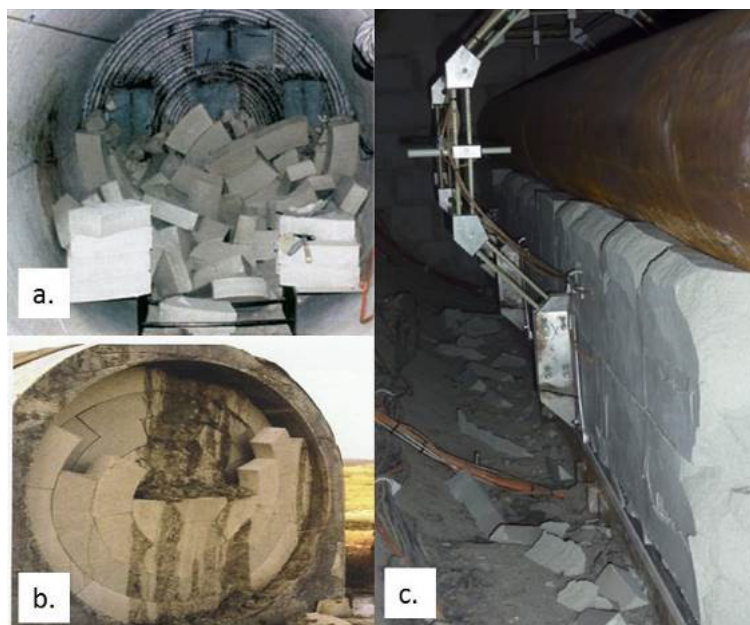
РИС. 9. Примеры, иллюстрирующие осложнения, возникающие при выполнении транспортно-технологических операций с сильно уплотненными бентонитовыми блоками и при их укладке в подземном пространстве.
