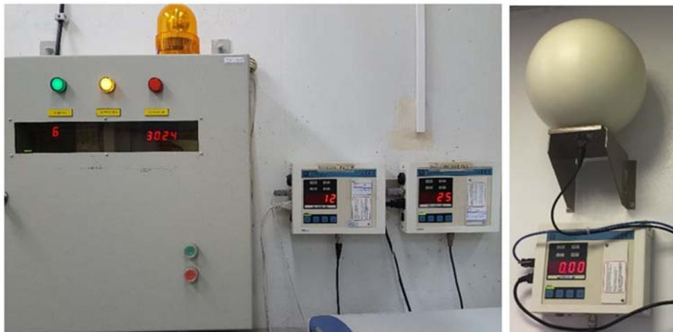
FIG. 15. Detector de área y alarmas asociadas a su funcionamiento.
