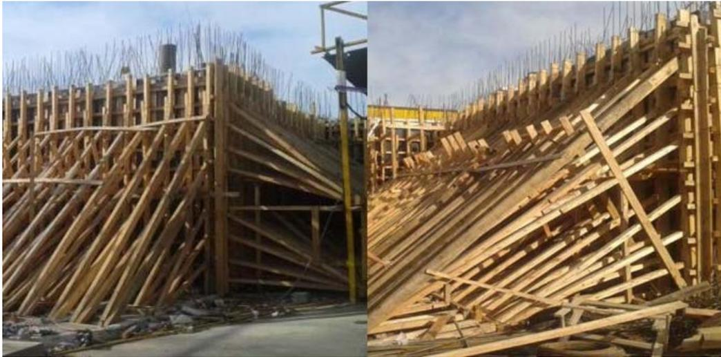
*FIG. 20. Sistemas de apuntalamiento externo al búnker.*
