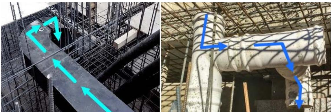
FIG. 22. Ductos con curvas a 90° sobre los 3 ejes espaciales (x-y-z).
