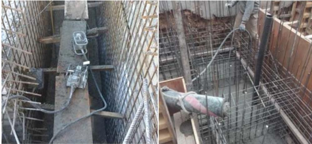
*FIG. 23. Vibrado del hormigón.*
