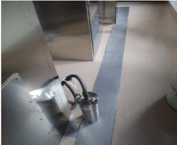
*FIG. 6. Canales en el suelo que contienen las líneas de transferencia.*
