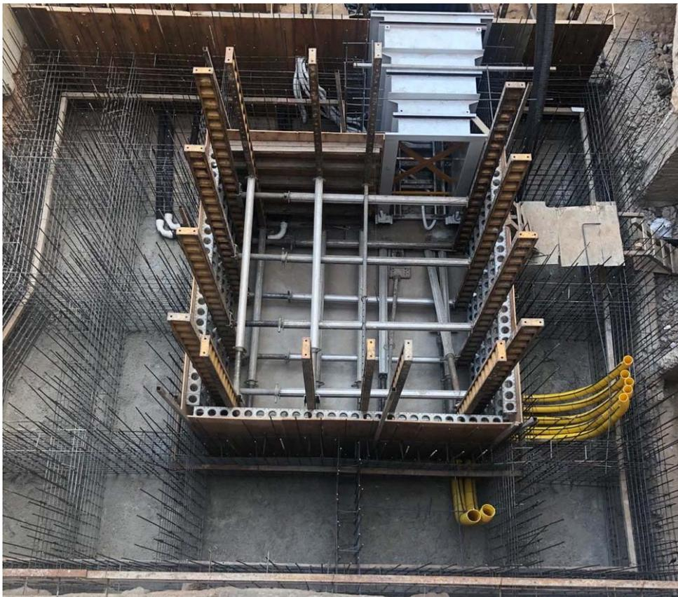
*FIG. 21. Sistema de apuntalamiento interno al búnker.*
