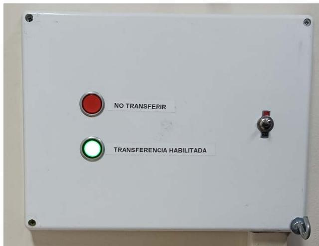
FIG. 13. Alarma de la transferencia del material producido en la sala de control.
