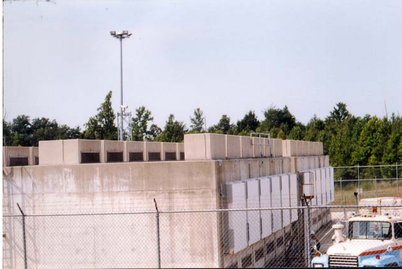
图 8. 卡尔弗特-克利夫斯核电厂 NUHOMS® 系统（美国核管会供图）。
