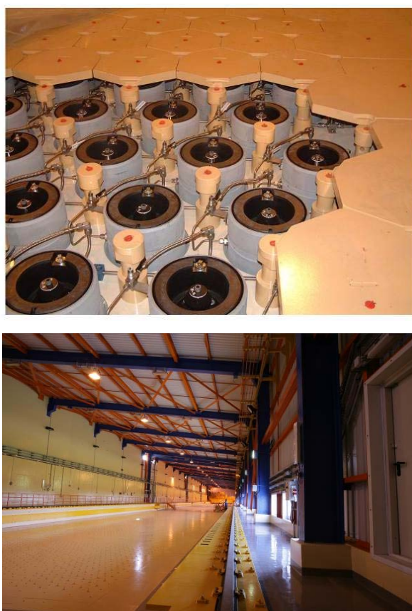
图 7. Paks 核电厂 MVDS 干法贮存设施，顶部视图和装料大厅 (由 PURAM 供图)。
