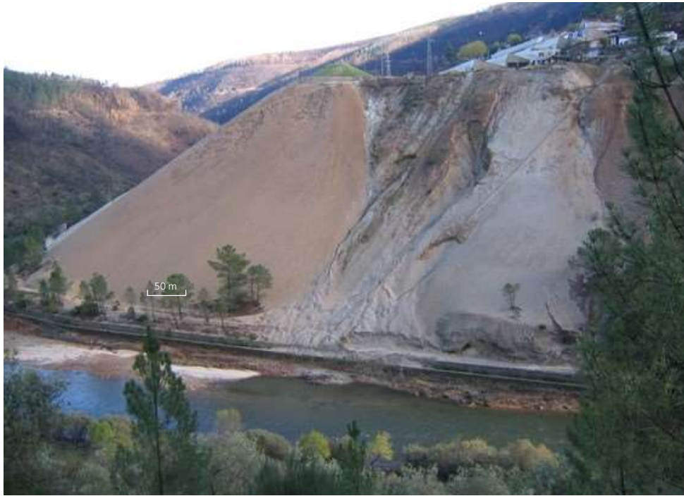
FIG. 12. Slope of the Cabeço do Pião tailings deposit.
