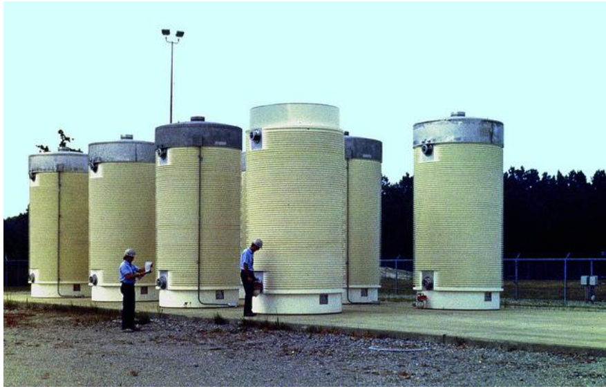
الشكل ٩ - براميل تخزين من نوع TN-32 في محطة سري للقوى النووية بالولايات المتحدة الأمريكية (الصورة مقدّمة من ملف صور NRC بالولايات المتحدة الأمريكية).
