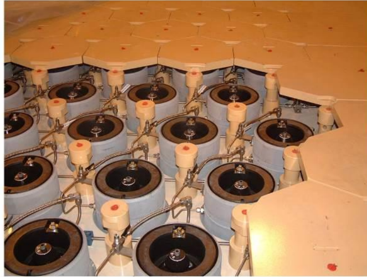
الشكل ٧- مخزن الأقبية النمائطي الجاف في محطة باكس للقوى النووية، المشغل هو الشركة العامة للتصرف في النفايات المشعة (PURAM)، هنغاريا. مناظر للسطح العلوي لأنابيب التخزين وقاعة الشحن (الصورتان مقدمتان من PURAM).
