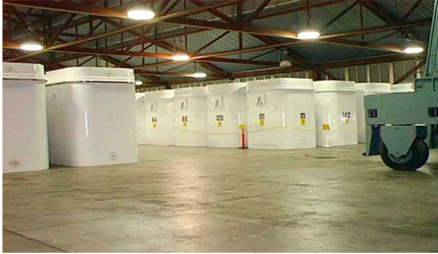
الشكل ١١ - براميل تخزين جاف لوقود مفاعلات كاندو (الصورة مقدمة من شركة أونتاريو لتوليد القوى الكهربائية).
