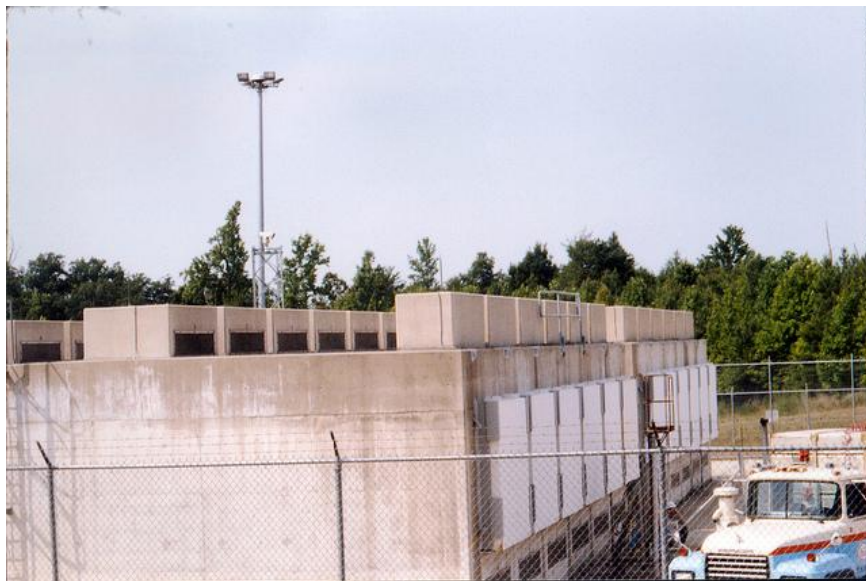
الشكل ٨- نظام NUHOMS® في كاليفيرت كليفر (الصورة مقدمة من ملف صور هيئة الرقابة النووية بالولايات المتحدة).
