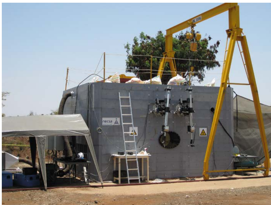
Fig. 38. Celda caliente móvil para el acondicionamiento de fuentes selladas de actividad alta.
