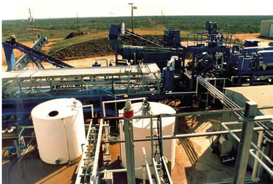
РИС. 7. Система промывки грунта (с разрешения компании «Энерджи солюшенз»).
