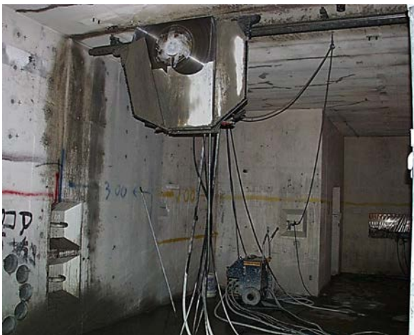
РИС. I-30. Резка бетонной стены (воспроизведено из [I-18] с любезного разрешения К. Масумото).
