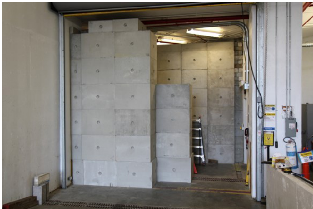
РИС. 15. Строящийся лабиринт у рамп, ведущей к корпусу Hall D Tagger в лаборатории Джефферсона (любезно предоставлено компанией Jefferson Science Associates, LLC).
