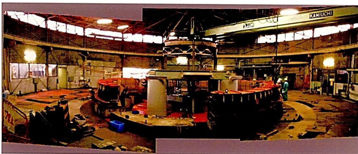
РИС. I-23. Демонтаж магнитов синхротрона (воспроизведено из [I-18] с любезного разрешения К. Масумото).
