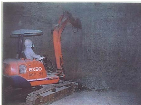
РИС. I-31. Сверление бетонной стены (воспроизведено из [I-18] с любезного разрешения К. Масумото).
