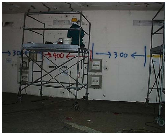
РИС. I-29. Разметка глубины дезактивации стены (воспроизведено из [I-18] с любезного разрешения К. Масумото).
