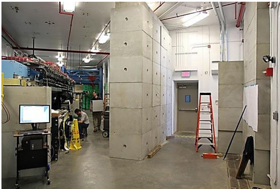
РИС. 16. Модульное защитное экранирование, используемое в Лаборатории Джефферсона (любезно предоставлено компанией Jefferson Science Associates, LLC).
