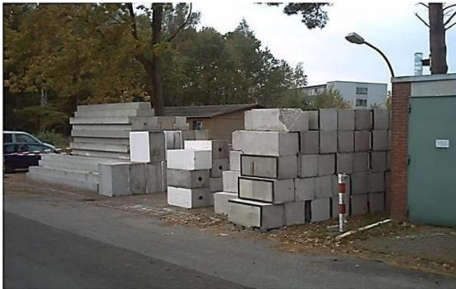
РИС. I–14. Балки крыши, блоки защитного экранирования и фрагменты стены (воспроизведено из [I–14] с любезного разрешения К. Пешеля).
