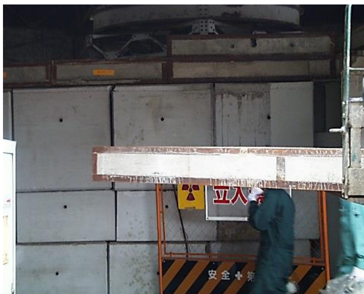
РИС. I-22. Удаление защитных блоков (воспроизведено из [I-18] с любезного разрешения К. Масумото).
