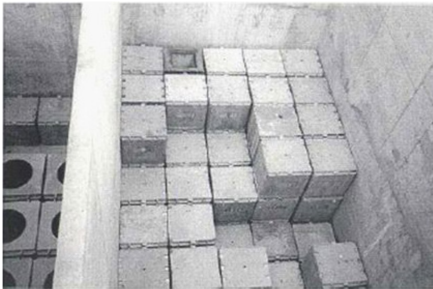
Fig. 77. Cámaras de hormigón utilizadas para alojar cajas de hormigón.
