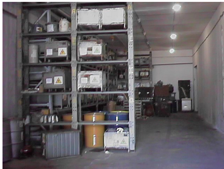
Fig. 63. Almacenamiento de fuentes DSRS en las estanterías.
