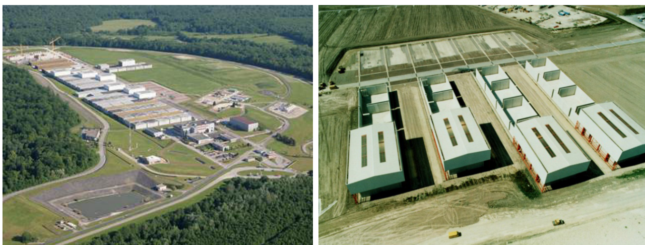
Fig. 108. Instalación en Centre de l'Aube (Francia) de disposición final cerca de la superficie para LLW (por cortesía de ANDRA).
