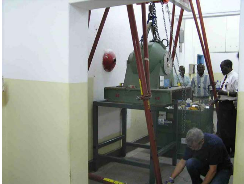
Fig. 55. Aparejado y elevación de un cabezal de teleterapia.
