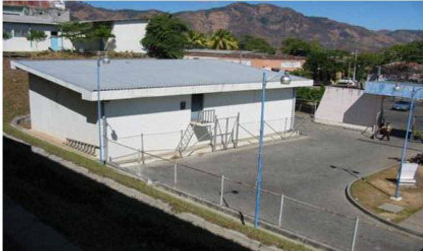
Fig. 61. Instalación de almacenamiento segura.
