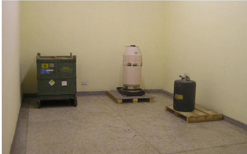
Fig. 64. Almacenamiento de fuentes DSRS sobre el suelo en una sala a prueba de intrusión.
