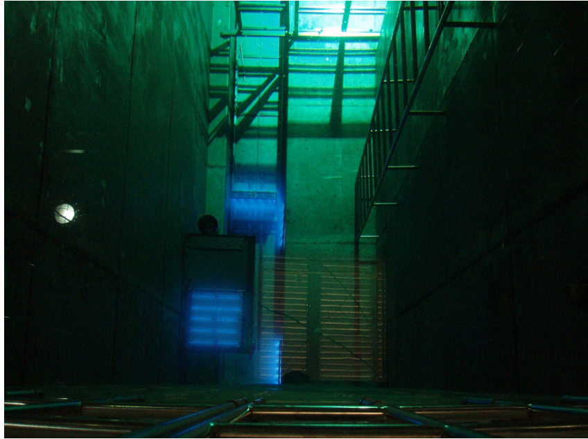
Fig. 7. Almacenamiento en húmedo de fuentes de la categoría 1 en la piscina de agua.
