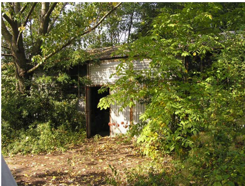
Fig. 69. Almacén de fuentes de radio visitado poco y sin regularidad.
