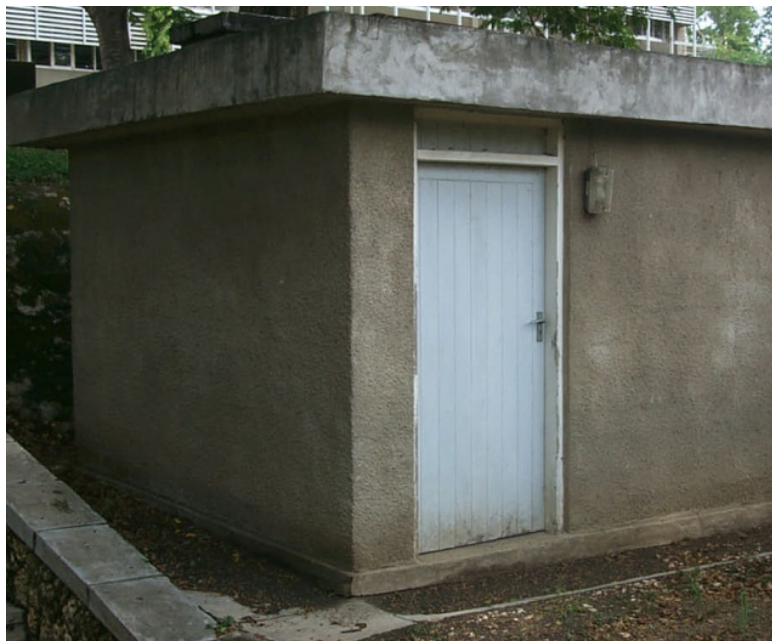
Fig. 72. Edificio de almacenamiento sin señal ni rótulo de aviso.
