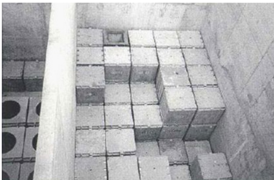
РИС. 77. Бетонные камеры, используемые для размещения бетонных контейнеров.
