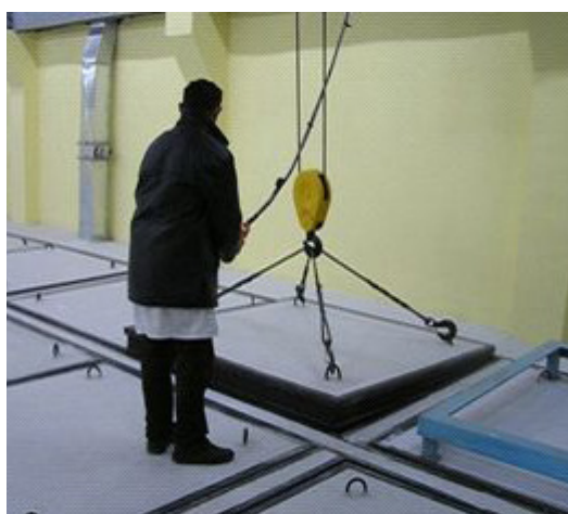
РИС. 65. Бетонное хранилище камерного типа для хранения ИЗРИ.
