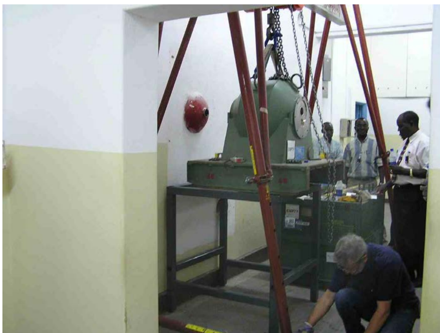
РИС. 55. Крепление и подъем головки аппарата для дистанционной лучевой терапии.
