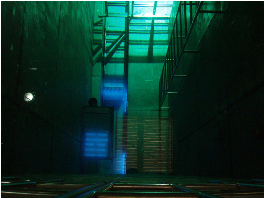
РИС. 7. Мокрое хранение источников категории 1 в бассейне с водой.
