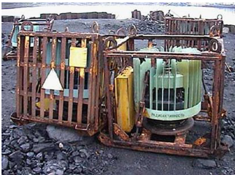
РИС. 74. Ненадлежащее открытое хранение РИТЭГ.
