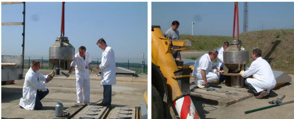
РИС. 75. Подготовка и загрузка в хранилище скважинного типа ИЗРИ, содержащих ^{60}\text{Co} .
