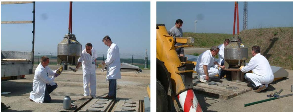
FIG. 75. Préparation et chargement de colis de sources radioactives scellées retirées du service au  $^{60}\text{Co}$  dans une installation d'entreposage en puits.
