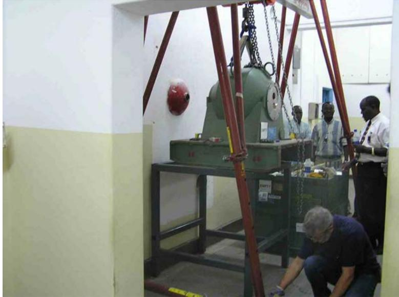
FIG. 55. Traction et levage d'une tête de téléthérapie.
