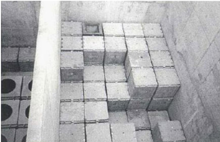
FIG. 77. Casemates en béton servant à l'entreposage de boîtes en béton.
