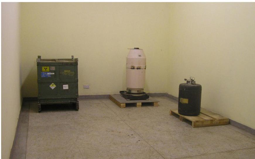
FIG. 64. Entreposage de sources radioactives scellées retirées du service au sol dans une pièce résistante aux intrusions.
