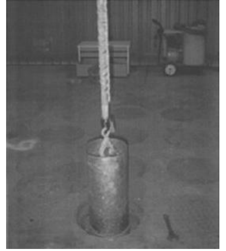
الشكل ٧٥- تحضير وتحميل المصادر المشعة المختومة المهملة للكوبالت-٦٠ في وحدة خزن من نوع الأبار.
