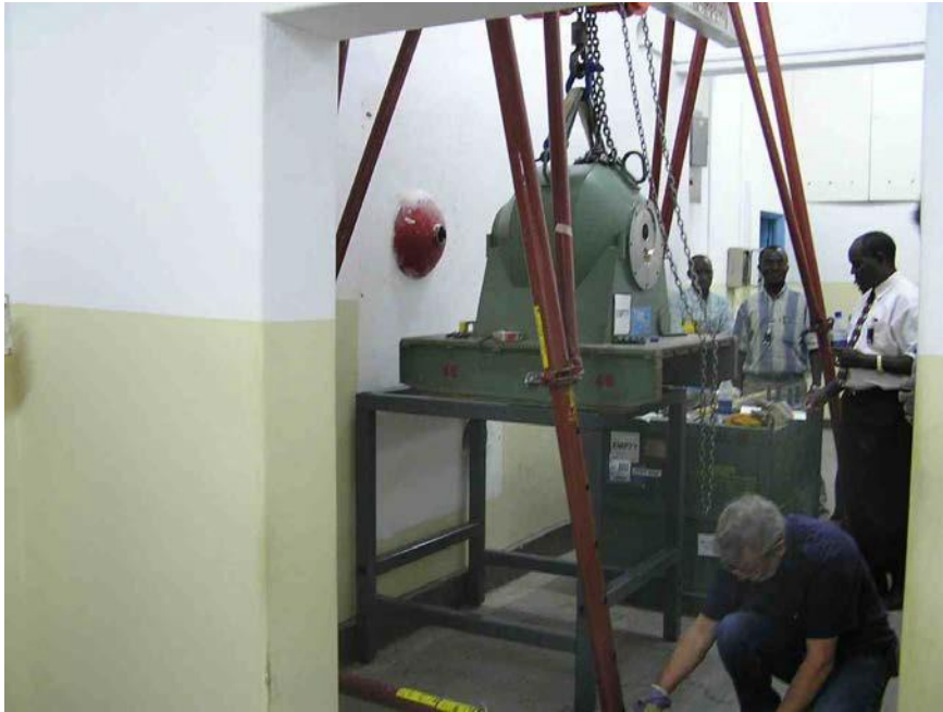
الشكل ٥٥- تركيب ورفع رأس جهاز معالجة بُعادية.
