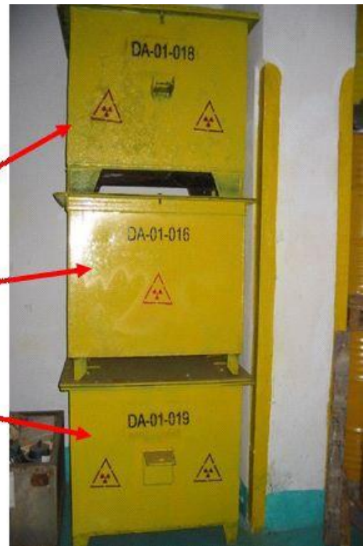
الشكل ٩١- وحدات المعالجة البُعادية قبل وبعد تكييفها داخل الصناديق المعدنية.
