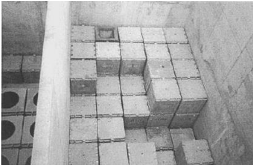
الشكل ٧٧- الأقبية الخرسانية المستخدمة لإيواء الصناديق الخرسانية.
