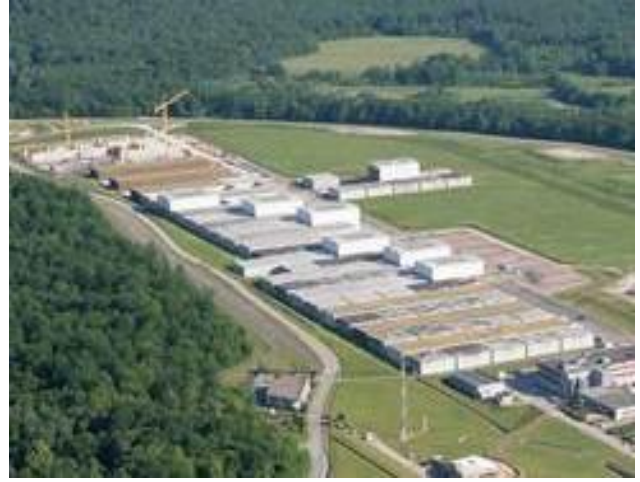
الشكل ١٠٨ - النفايات الضعيفة الإشعاع في مركز دولوب، وهو مرفق تخلص بالقرب من سطح الأرض مصمم هندسياً في فرنسا (الصورتان مهادتان من وكالة "أندرا").
