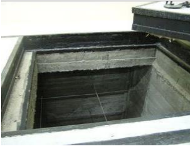
الشكل ٦٥ - قبو خرساني لخزن المصادر المشعة المختومة المهمة.
