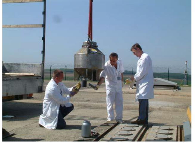
الشكل ٧٥- تحضير وتحميل المصادر المشعة المختومة المهملة للكوبالت-٦٠ في وحدة خزن من نوع الأبار.
