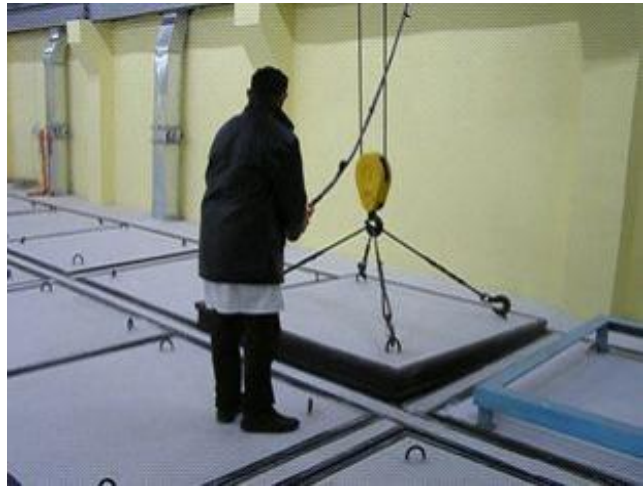
الشكل ٦٥ - قبو خرساني لخزن المصادر المشعة المختومة المهمة.
