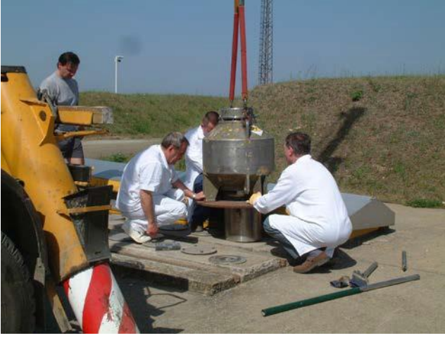
الشكل ٧٥- تحضير وتحميل المصادر المشعة المختومة المهملة للكوبالت-٦٠ في وحدة خزن من نوع الأبار.
