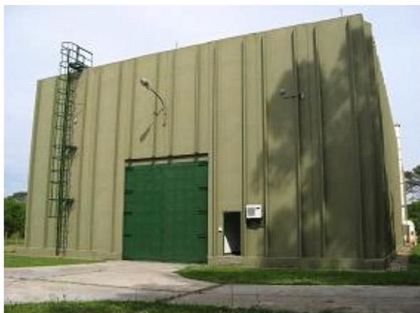
*Fig. 10.1. Edificio con armazón de hormigón armado y techo plano construido in situ.*
