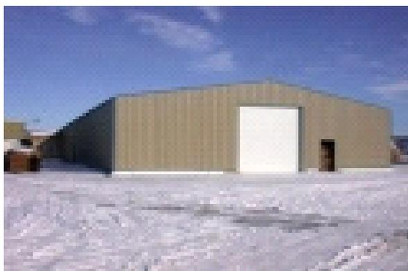
*Fig. 10.3. Edificio con armazón de acero, revestimiento de metal y aislamiento térmico, de techo inclinado.*
