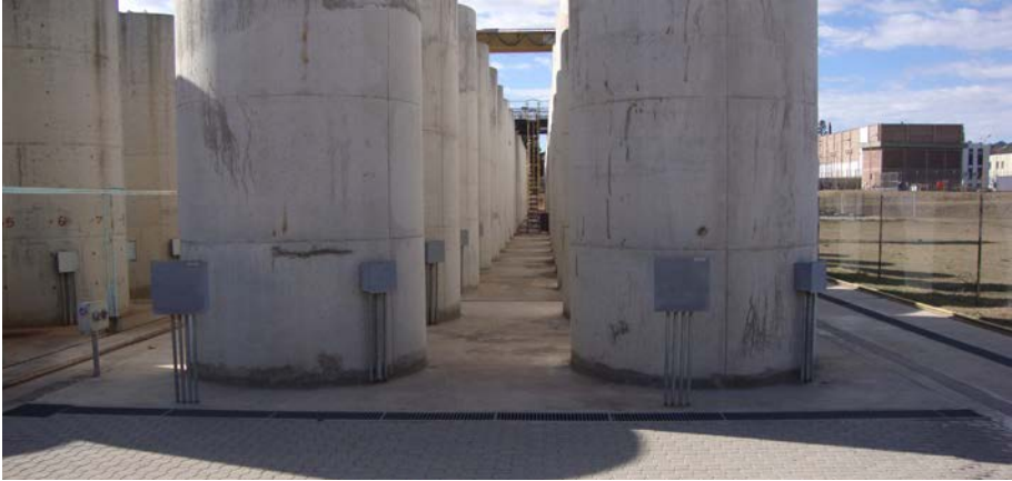
FIG. 30. Dry storage at Embalse NPP, Argentina (courtesy of Comisión Nacional de Energía Atómica/CNEA).
