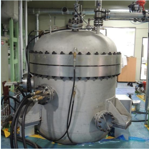
Furnace vessel (VESTA)
