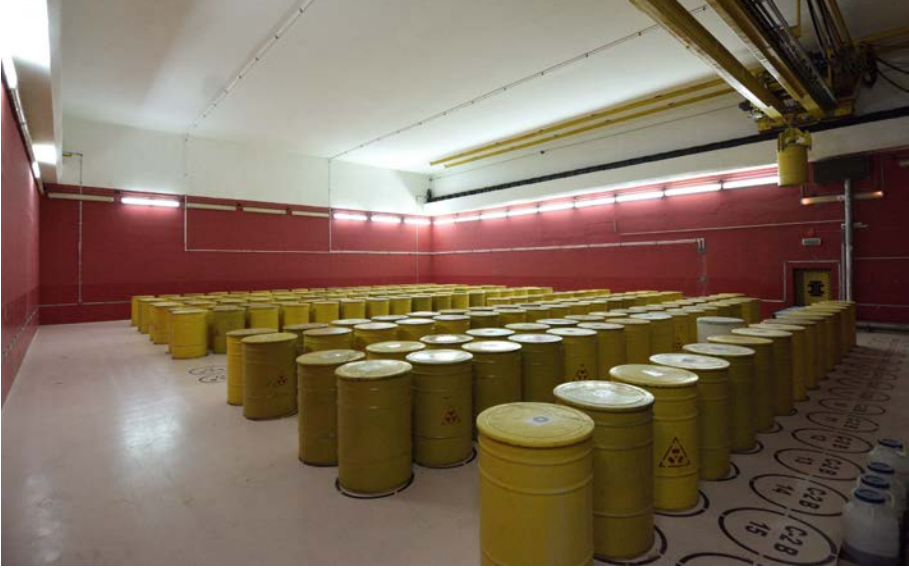
الشكل-49- قاعة لخرن السوائل المعالجة في محطة تشرنوبل لمعالجة النفايات المشعة السائلة. بإذن من المؤسسة الحكومية المتخصصة "محطة تشرنوبل للقوى النووية".
