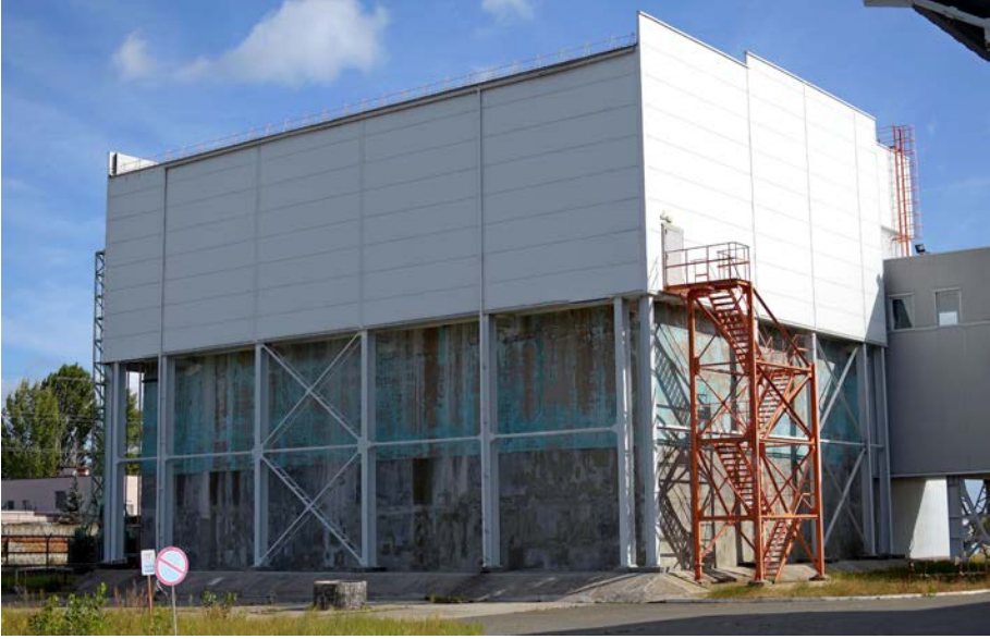
الشكل-22- منشأة استرداد النفايات المشعة الصلبة في المجمع الصناعي للتصرف في النفايات المشعة الصلبة، تشرنوبل. بإذن من المؤسسة الحكومية المتخصصة "محطة تشرنوبل للقوى النووية".
