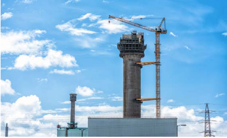
الشكل-20- تركيب رافعة بطول 152 م في سيلافيلد لهدم مدخنة 1 Windscale Pile. بإذن من الهيئة النووية المعنية بالإخراج من الخدمة.
