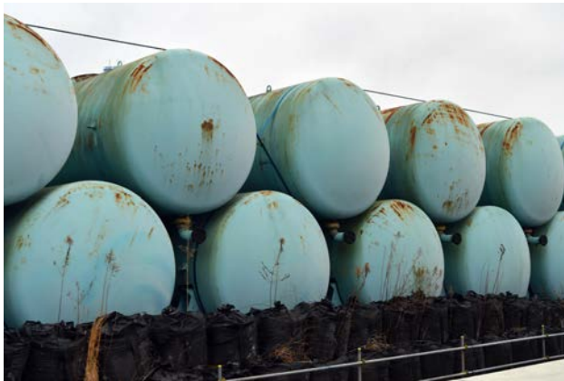
الشكل-46- صهاريج خزن المياه الملوثة في محطة فوكوشيما دايتشي للقوى النووية.
