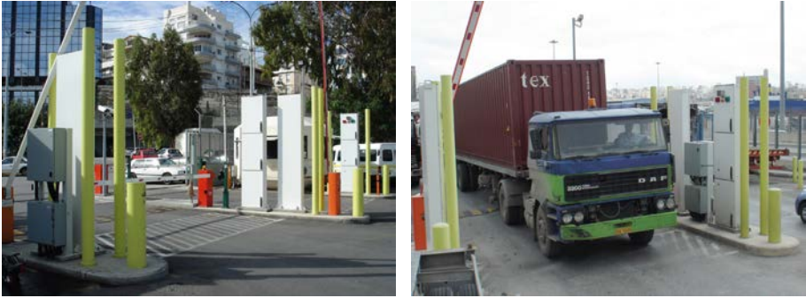
Fig. V-5. Ejemplo típico de un pórtico detector de radiación para vehículos instalado en un punto de entrada.
