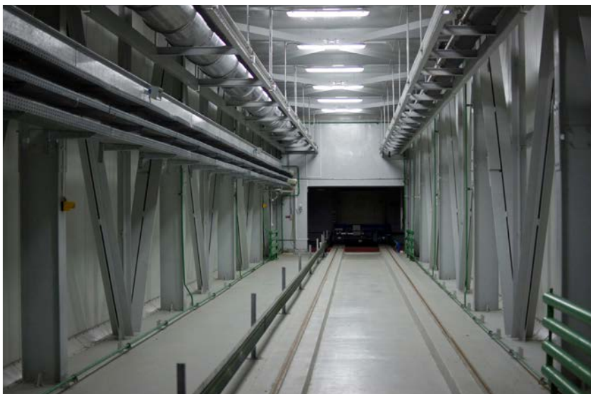
РИС. 23. Специальная галерея с дистанционным управлением для перемещения контейнеров с отходами, соединяющая черновильскую УИТРО с ЗПТРО. Публикуется с разрешения Государственного специализированного предприятия «Черновильская АЭС».
