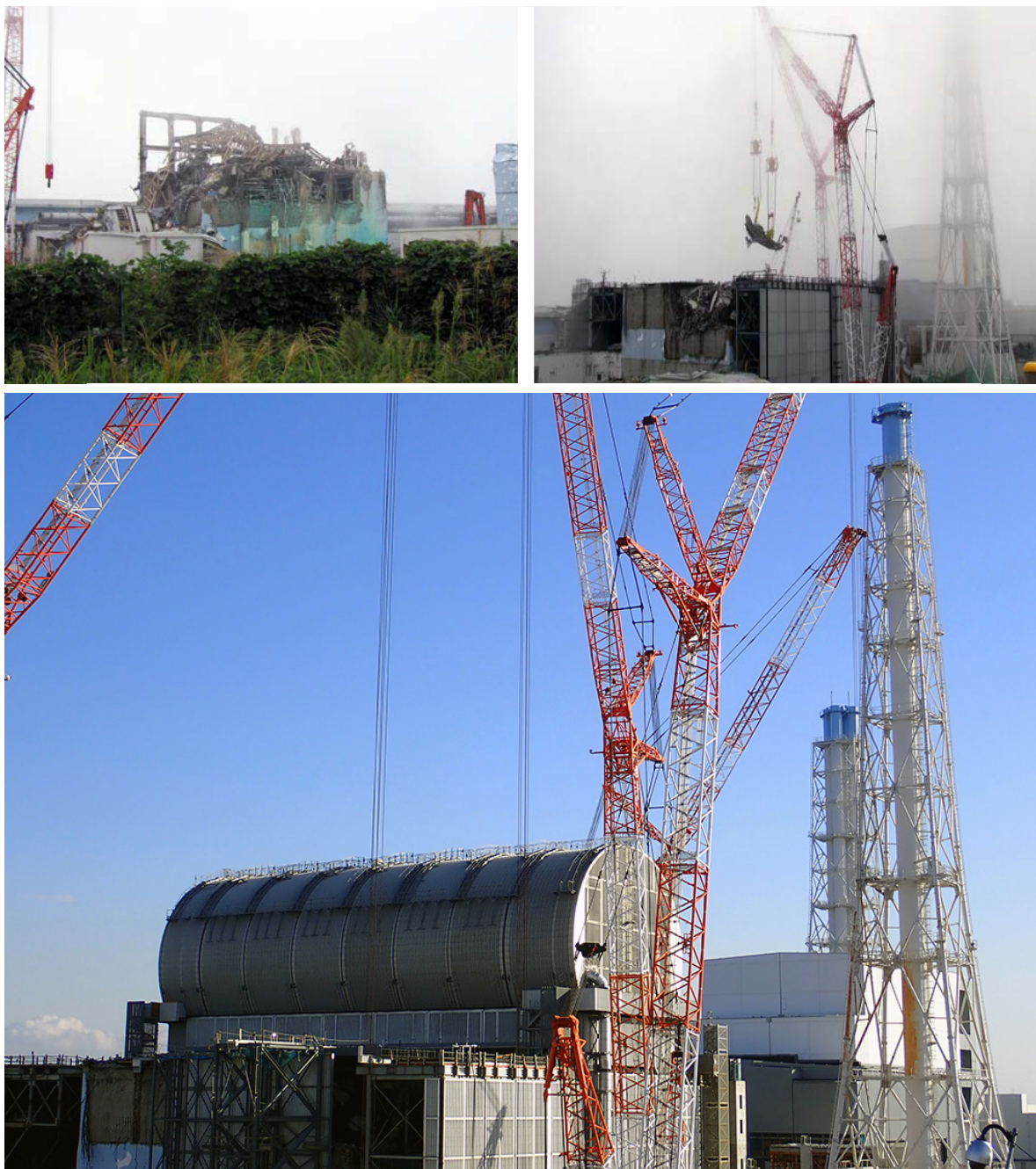
РИС. 18. Разбор завалов и стабилизация при помощи кранов на энергоблоке № 3 АЭС «Фукусима-дайити»: после аварии — 2011 год (вверху слева); во время разбора завалов — 2015 год (вверху справа); текущая стабилизированная ситуация — 2020 год (внизу). Две верхние фотографии публикуются с разрешения Токийской электроэнергетической компании.
