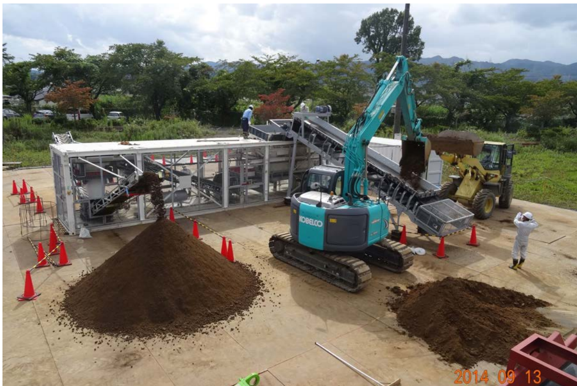
РИС. 27. Установка для сортировки загрязненного грунта, использовавшаяся на АЭС «Фукусима-дайити». Публикуется с разрешения GRS VALTECH.
