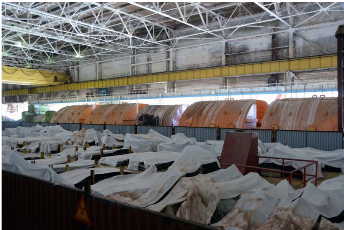
РИС. 6. Временное (буферное) хранилище в машинном зале энергоблока № 3 Чернобыльской АЭС с фрагментами демонтированных вентиляционных труб с энергоблоков № 3 и № 4. Публикуется с разрешения Государственного специализированного предприятия «Чернобыльская АЭС».
