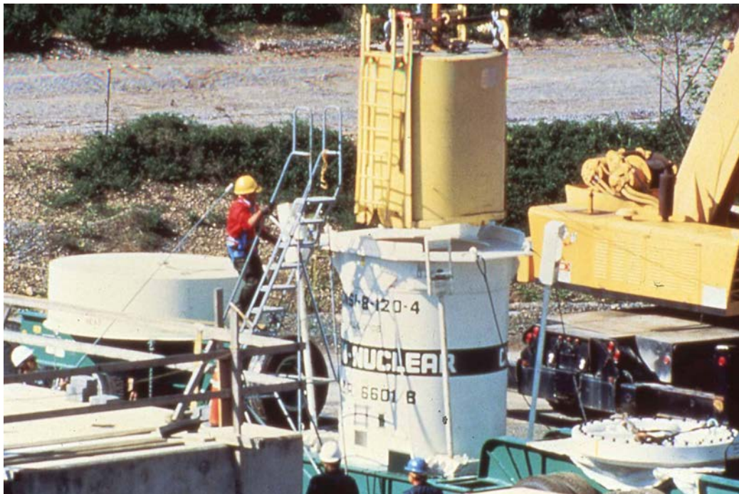
РИС. 42. Контейнер CNS 14-190 проходит инспекцию на АЭС ТМА. Публикуется с разрешения Айдахской национальной лаборатории [25].
