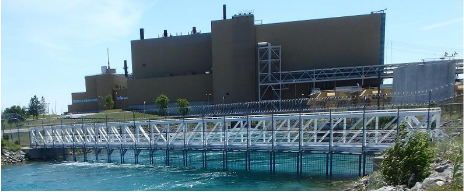
FIG. 38. Barrière ancrée sur le littoral (reproduit avec l'aimable autorisation de la Commission canadienne de sûreté nucléaire)
