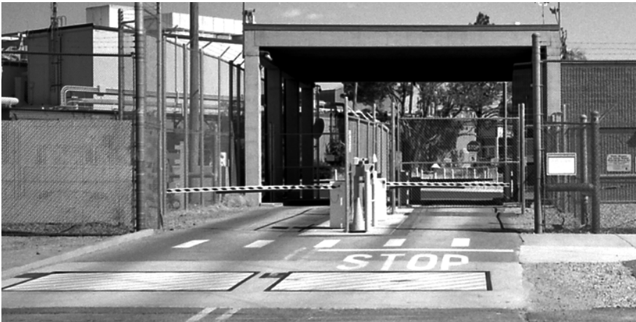
FIG. 21. Portique de contrôle d'accès des véhicules (reproduit avec l'aimable autorisation des Laboratoires nationaux Sandia)
