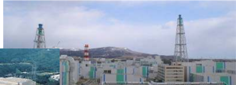
Rokkasho Reprocessing Plant (JNFL)
