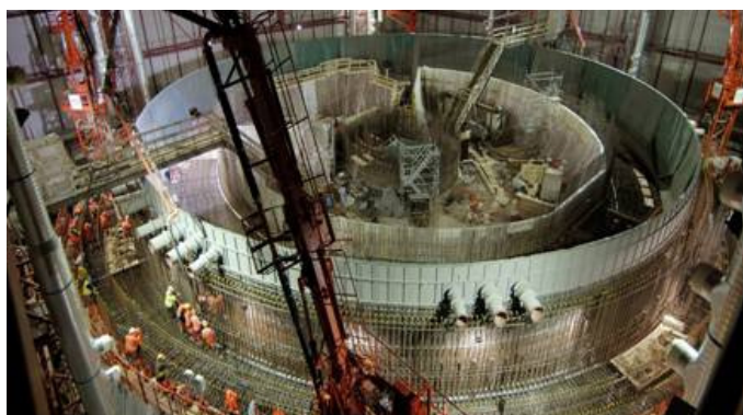
Construction of Olkiluoto-3 (2007) [credit: Teollisuuden Voima Oy (TVO)]
