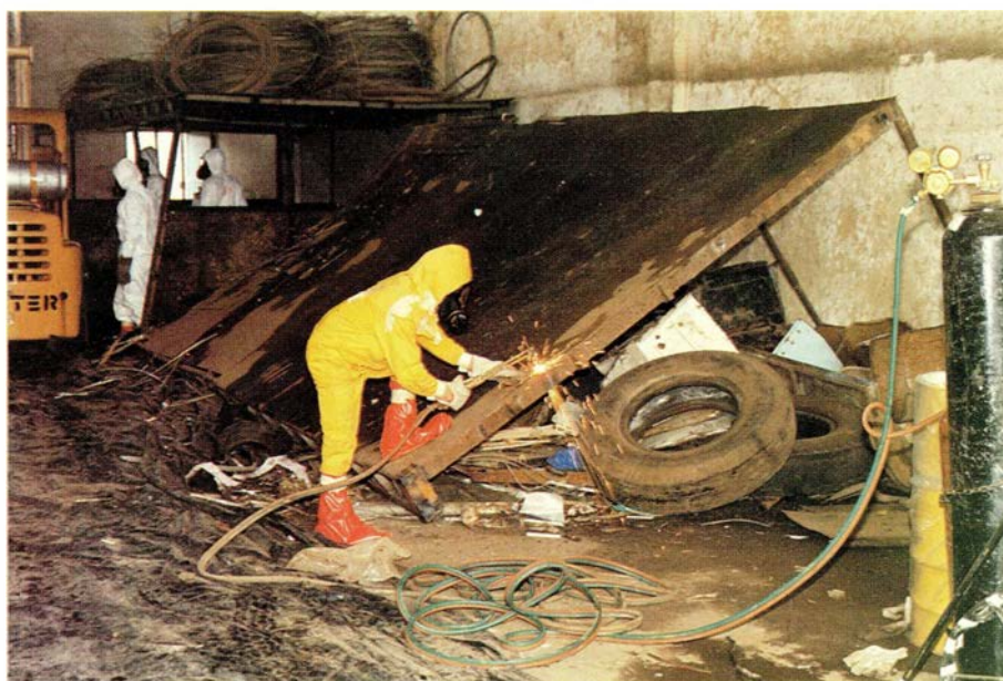
16. Cortando elementos contaminados para sacarlos del almacén del depósito de material de rezago III.
