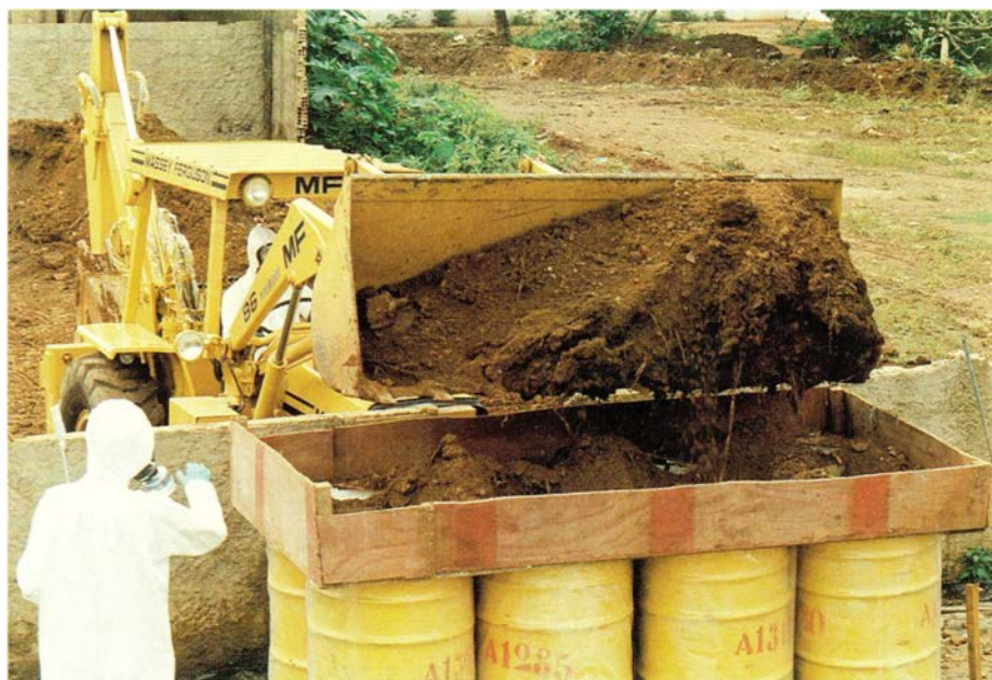
18. Una manera improvisada de llenar simultáneamente ocho tambores con suelo contaminado.
