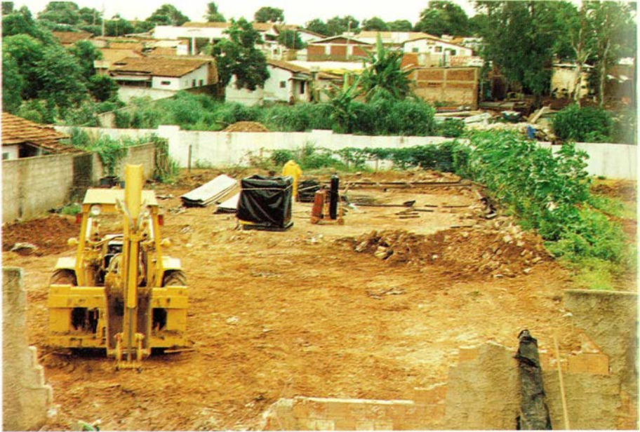
11. Limpiando el lugar donde se encontraba el depósito de material de rezago II, en la Rua (calle) 6.
