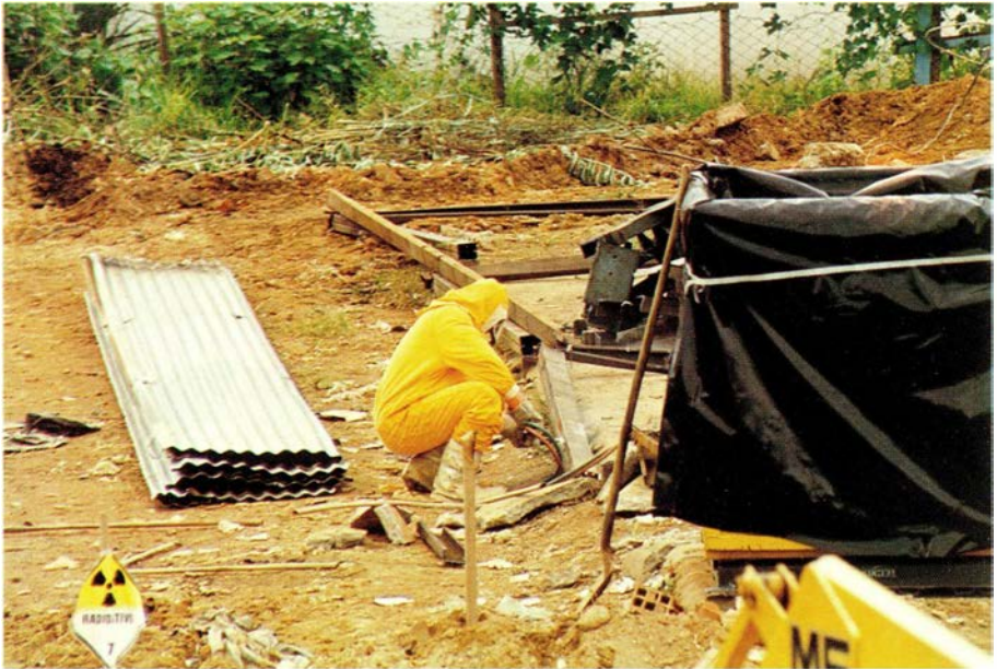
12. Depósito de material de rezago II: cortando barras de metal contaminadas.
