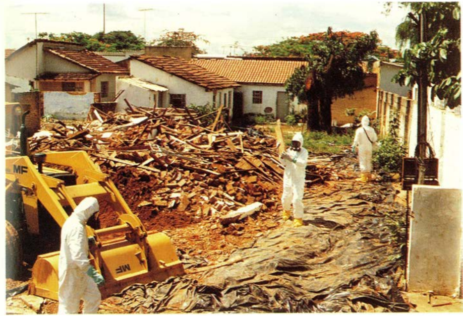
13. Escombros contaminados de la demolición de la casa de R.A. en la Rua (calle) 57.
