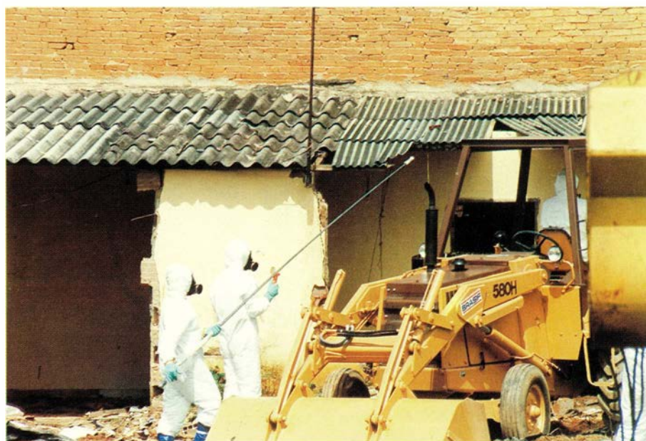
8. Monitoreando el techo de la casa de E.F.2 y S.F.1 durante la demolición.
