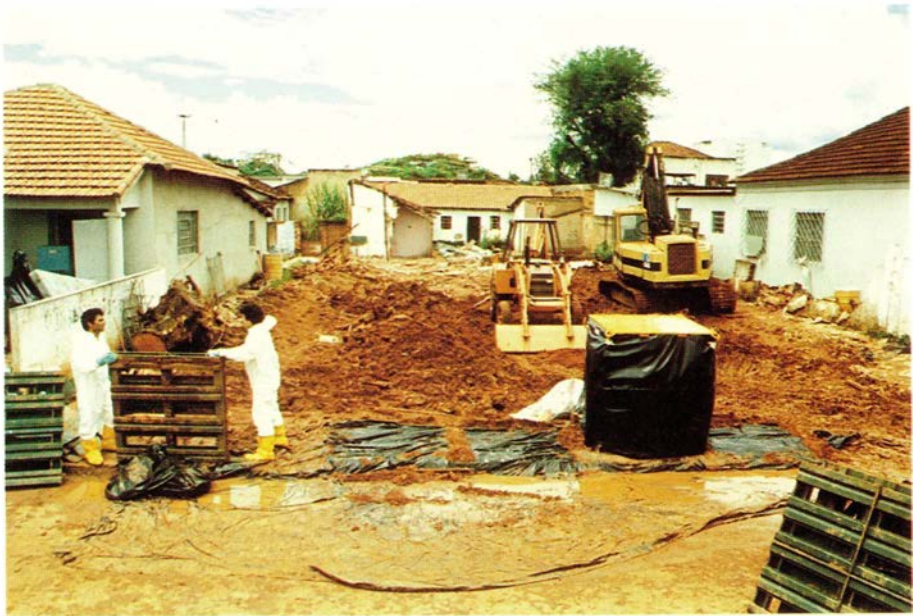
14. El mismo lugar después de la remoción de los escombros contaminados.
