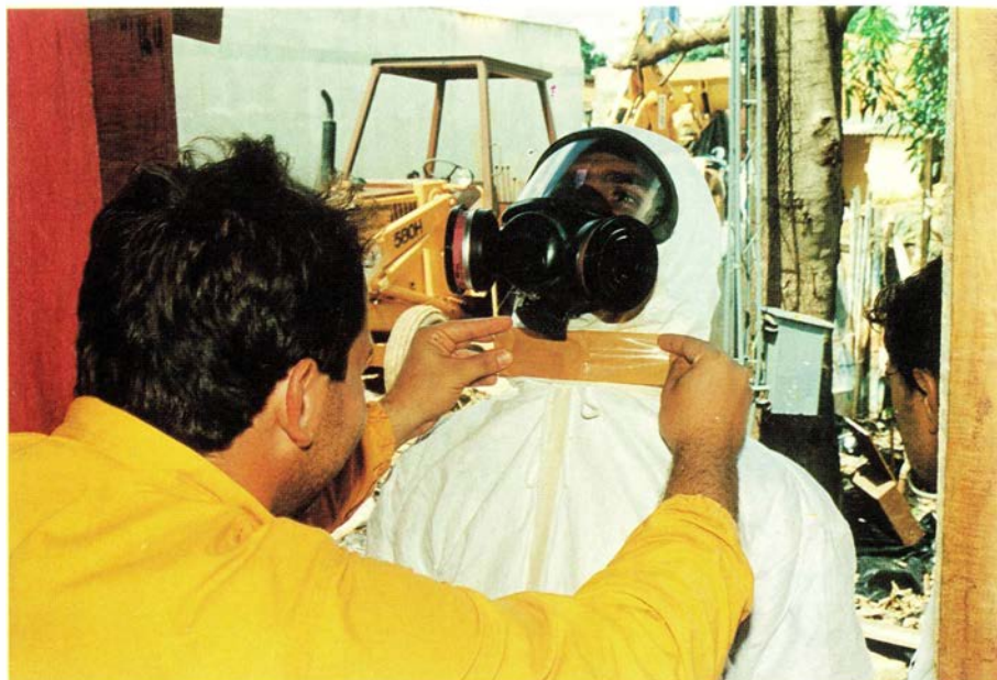
7. Preparando la demolición de la casa de E.F.2 y S.F.1, cercana al depósito de material de rezago I.
