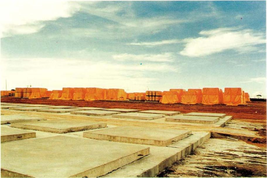
24. *Site de stockage provisoire; dalles de ciment et rigoles d'échantillonnage de l'eau de ruissellement.*
