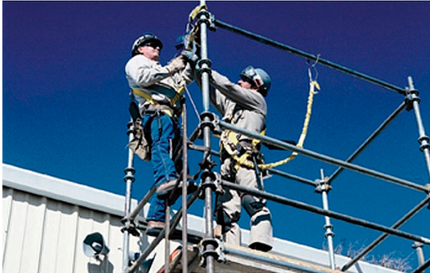
FIG. 51. Workers tied when dismantling scaffolding (courtesy of Électricité de France).
