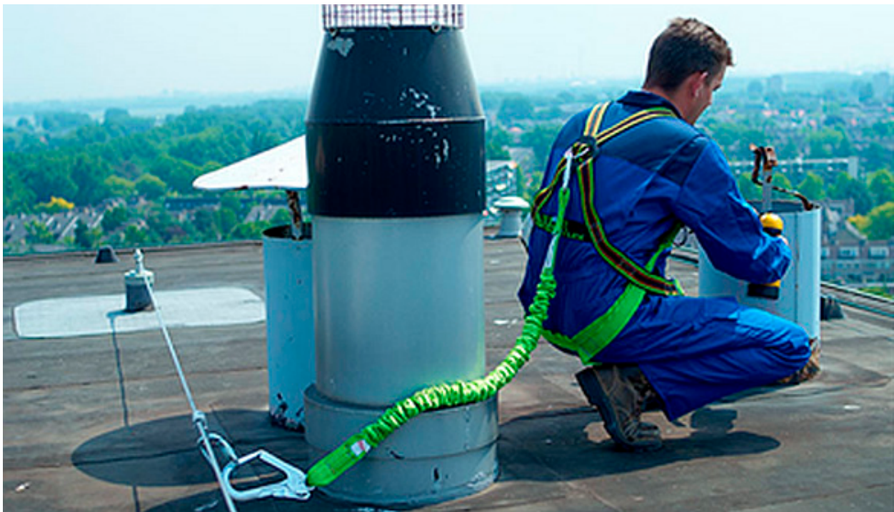
FIG. 50. Travel restraint system for use on a roof (courtesy of Électricité de France).
