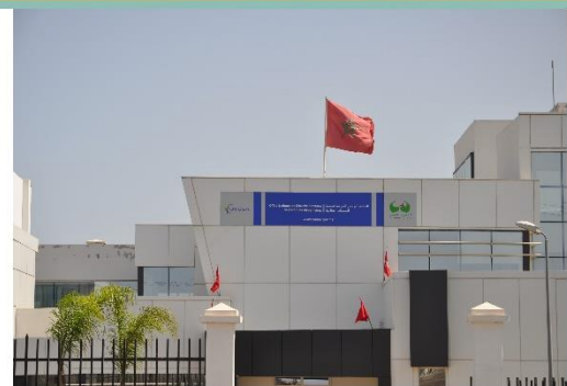
Headquarters of the Office National de Sécurité Sanitaire des Produits Alimentaires in Morocco
